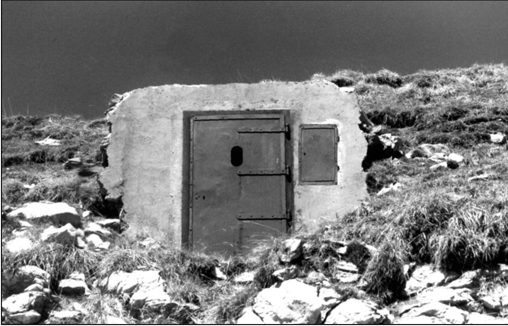
Figure 62 : Chambre de coupure construite à contre pente , Alpes - Photo JL NOSPELD
