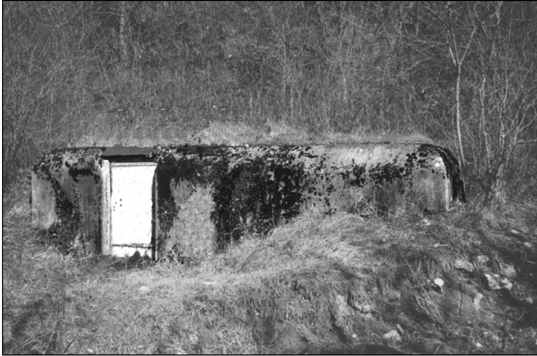
Figure 58 : Chambre de coupure 29M , construite à flanc de colline . Photo JLN
